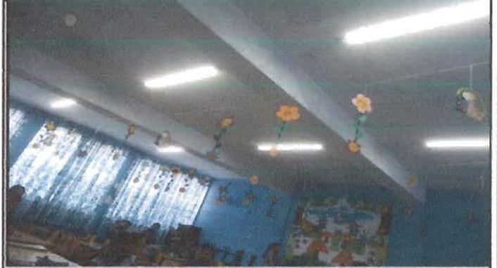
Foto 2: reemplazo de lamparas de tubos por lámparas led en aulas
