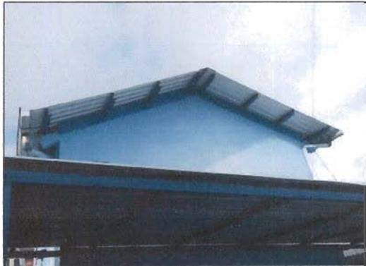
foto 10. colocación de material prefabricado para cerrar espacios entre pared y techo.
