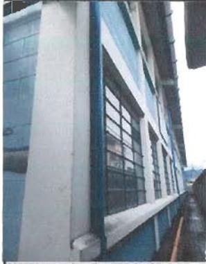
Foto 1: Colocación de canales y bajadas de aguas pluviales que salpicaban paredes y hmedecian aulas
