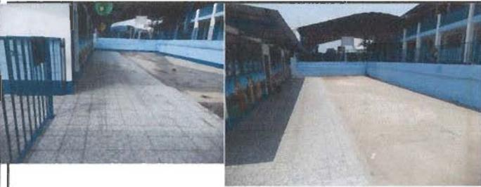
foto 5. demolición de gradas del fondo y construcción de pared y torta de piso de cemento.
